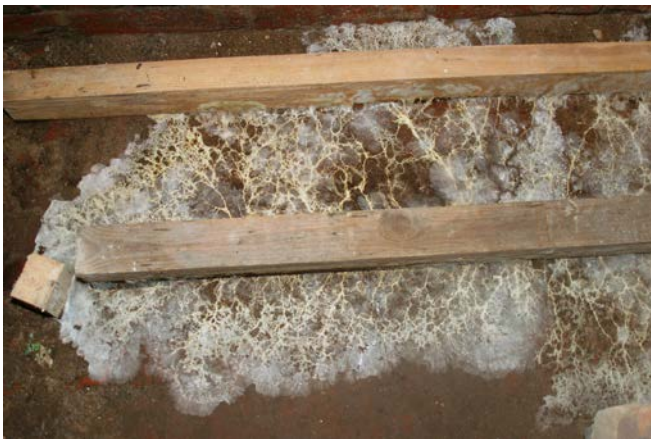
Bild 6: Beginnender und überschaubarer junger Schwammbefall, Ausbau und Reinigung kann ausreichend sein.
