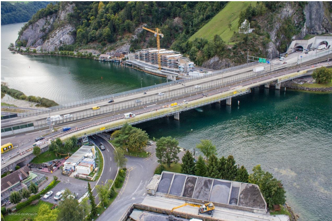
[Ansicht der Achereggbrücke während der Instandsetzung]
