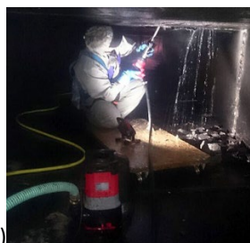
[Abb. 1: Abdichtung Wassereintritt] [Abb. 2: XYPEX Kristallbildung] [Abb. 3 und 4: Abdichtung Mischwasserdüker in Hemer]
