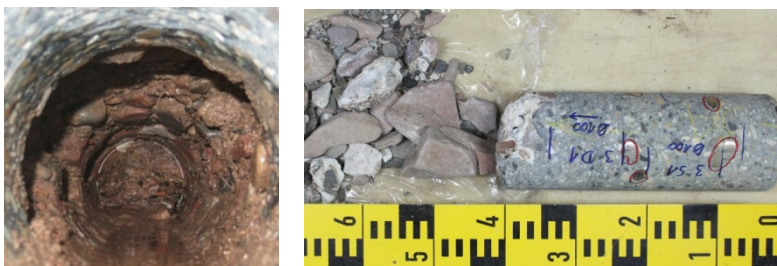
Bild 1: Altbeton und Vorsatzschalenbeton einer alten Wehranlage - Bohrloch und Bohrkern
