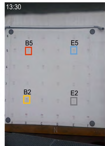
Wandoberfläche teilweise abgetrocknet, Feld B2 noch leicht verfärbt
