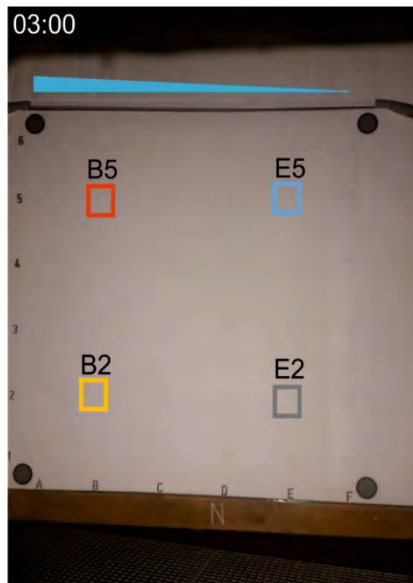
Wandoberfläche im trockenen Zustand
