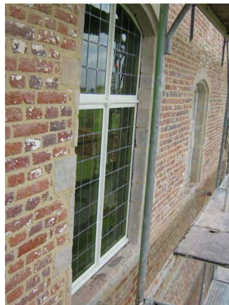
Foto 36: Meise, pas torij v an Meuzegem, achttiende-eeuws raam, na restauratie. (© Gisèle Gantois)
