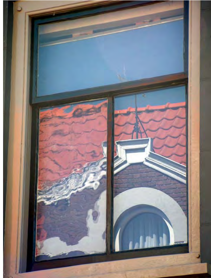
Figuur 2: Het verschil tussen mondgeblazen glas (links) en het sterk spiegelende floatglas. [Bronvermelding] Foto: Taco Hermans
