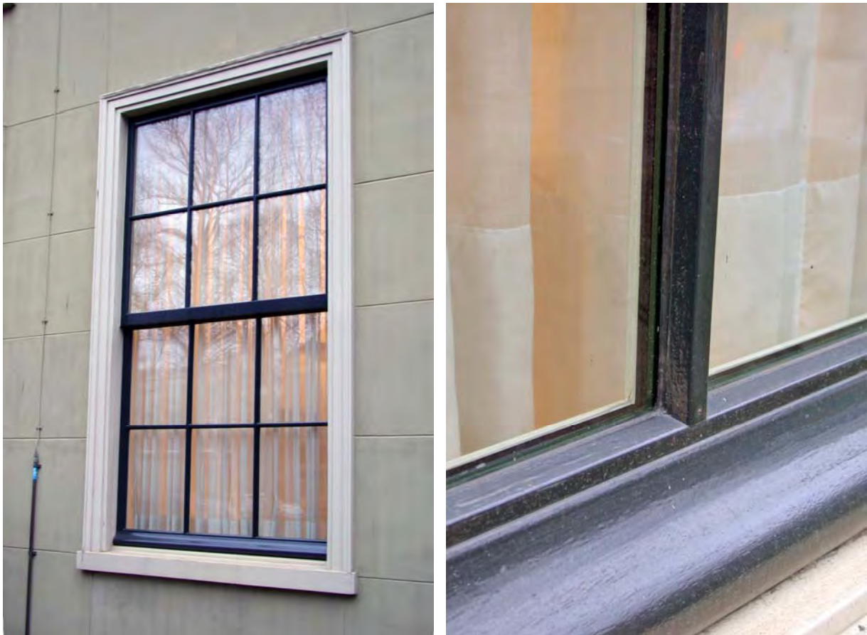
Figuur 7a en 7b: Voorbeeld van een schuifvenster met dun dubbel glas. Doordat de afstandhouder tussen het glas is geverfd in de kleur van het raamhout is deze ook van nabij vrijwel niet zichtbaar (zie detailfoto). [Bronvermelding] Foto: Taco Hermans
