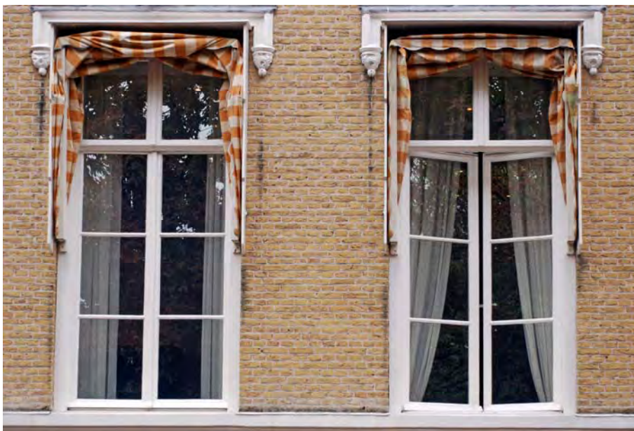
Figuur 9: Twee historische vensters met stolpramen. Links oorspronkelijk, rechts met vacuümglas. Het verschil is vrijwel niet zichtbaar. [Bronvermelding] Foto: Taco Hermans
