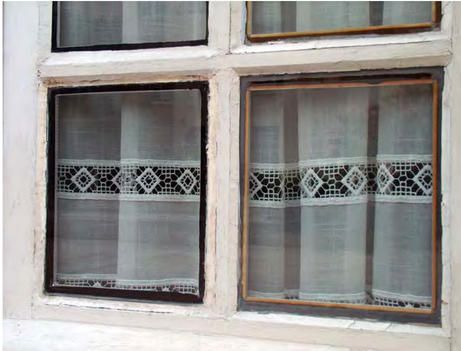
Figuur 8: Historische ramen laten vaak het plaatsen van dubbel glas niet toe. Hier zijn duidelijk de afstandhouders tussen het glas zichtbaar. [Bronvermelding] Foto: Taco Hermans
