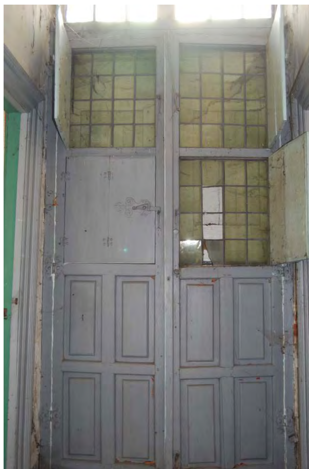
Foto 10: Meise, pastorie van Ophem, balkondeur interieur. (© Dirk Snauwaert)
