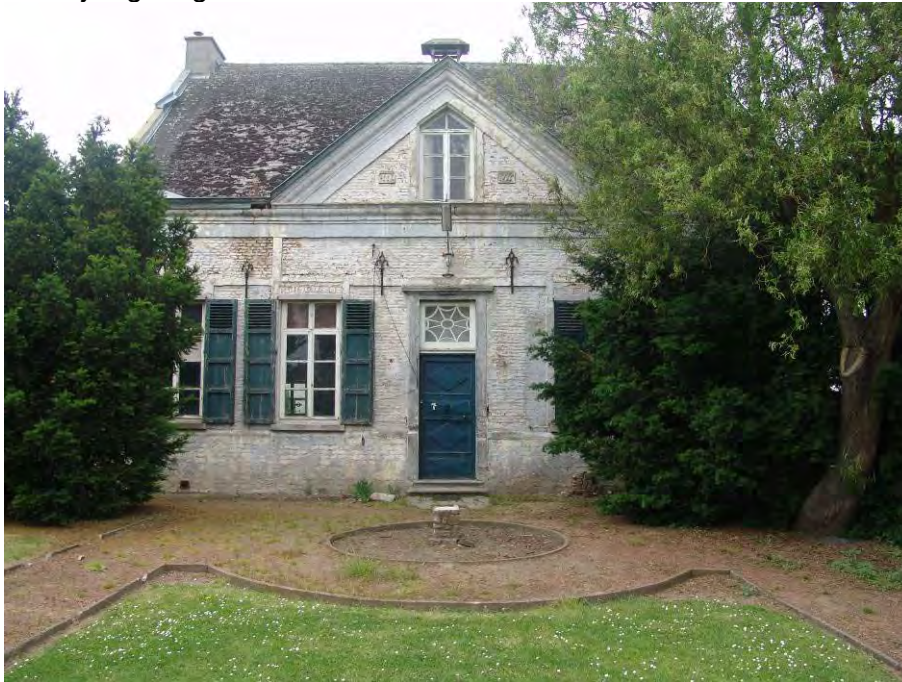
Foto 30: Meise, pastorie van Meuzegem, voorgevel (© Gisèle Gantois)
