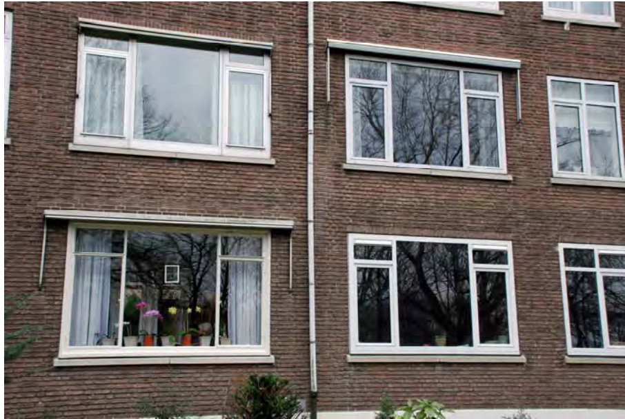
Figuur 1: Dit appartementengebouw is gebouwd met stalen kozijnen. Linksonder zijn deze nog zichtbaar, alleen het glas-in-lood in de bovenlichten is verwijderd. De andere kozijnen zijn vervangen door kunststof of aluminium, met een storend beeld tot gevolg. [Bronvermelding] Foto: Taco Hermans
