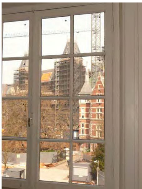
Figuur 14: In een historisch raam toegepaste vacuüm glaspanelen. Links: Let op de vacuümventielen. Rechts: detail vacuümventiel. Foto's: Marc Stappers, RCE
