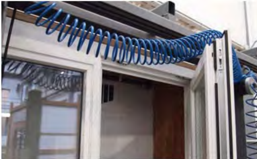
Figuur 8: Ventilatie opening in de middendichting
