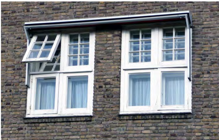
Figuur 4: Zogenaamde 'Kastfenster' in het Collegium Berchmanianum te Nijmegen. [Bronvermelding] Foto: Taco Hermans
