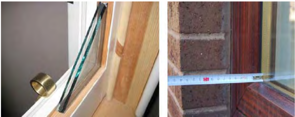
Figuur 21: Slanke profiel dubbele beglazing heeft een smallere spouw en daardoor een beperkte totale dikte, in vergelijking tot conventionele dubbele beglazing. Bron: Baker, 2008
