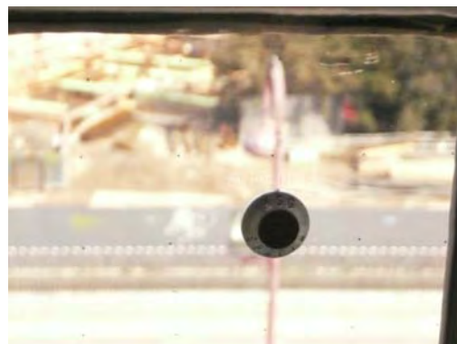
Figuur 14: In een historisch raam toegepaste vacuüm glaspanelen. Links: Let op de vacuümventielen. Rechts: detail vacuümventiel. Foto's: Marc Stappers, RCE
