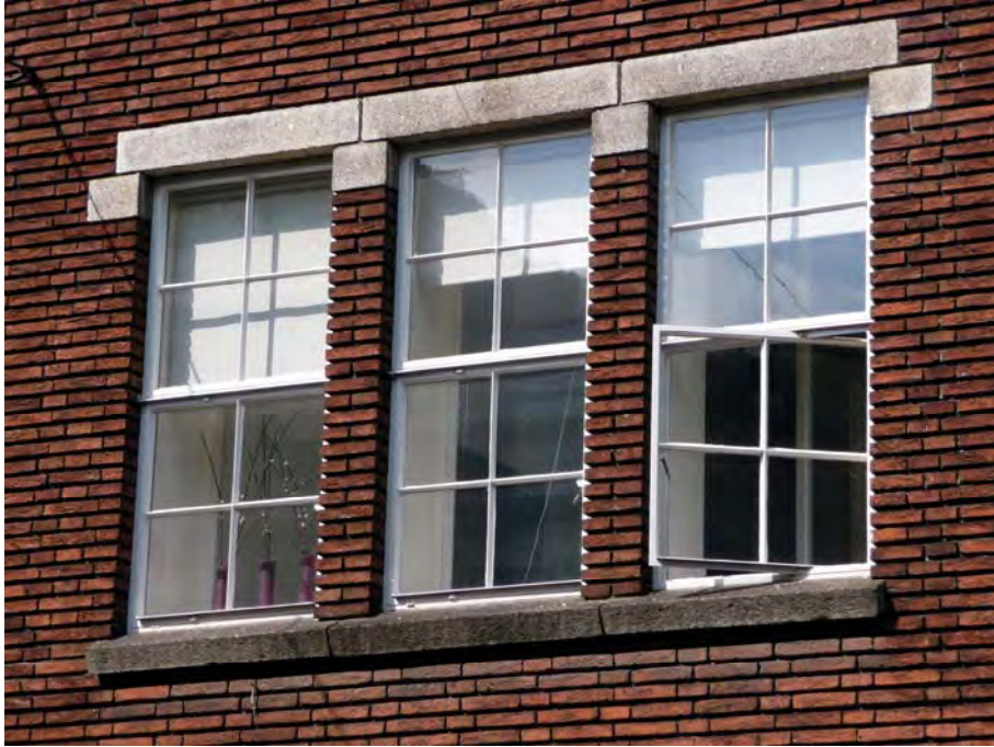
Figuur 3: Stalen ramen met daarachter nauwelijks zichtbare achterzetbeglazing. [Bronvermelding] Foto: Taco Hermans
