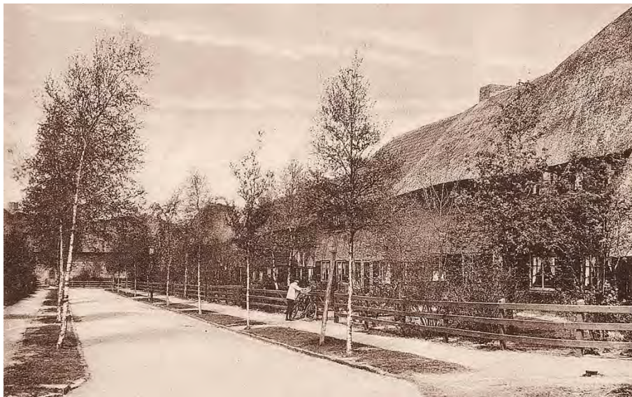
Figuur 6: Hetzelfde rijtje huizen op een oude anzichtkaart: opmerkelijk is dat de nu gekoesterde dakpannen helemaal niet bij de oor spronkelijke opzet behoorden. Bij de oplevering was het rijtje huizen voorzien van rieten kappen.
