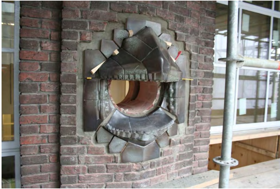
Fig. 5: Replica van een 'zuurkastopening'
