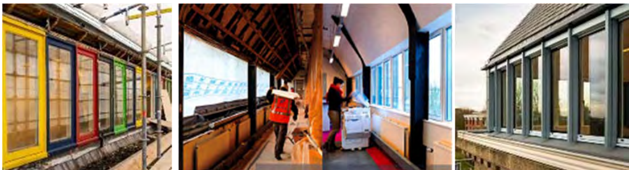
Fig. 8: (Respectievelijk) Voormalige dakraamstrook aan de buitenzijde, aanpassingen binnenzijde tijdens verbouwing en resultaat, de nieuwe dakraamstrook aan de buitenzijde.
