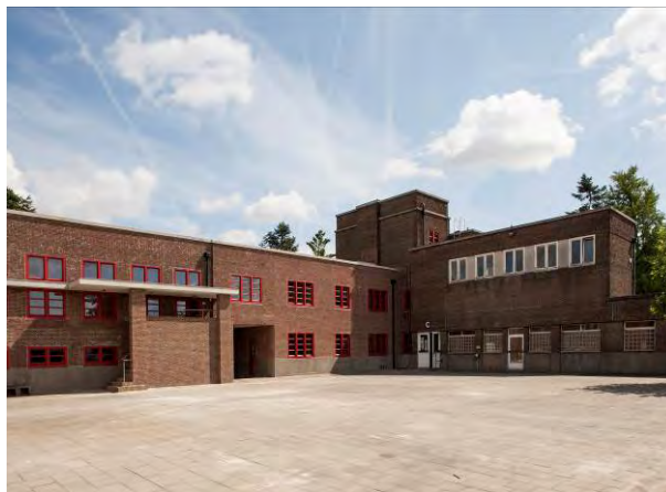
Fig. 6: Achterzijde van het gebouw na de eerste restauratiefase met rechts de nog niet gerestaureerde vleugel met de voormalige bibliotheek (foto O. Pauwels)
