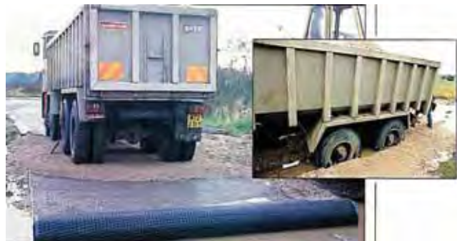
Fig. 9: Voorbeeld geogrids en toepassing in de weg
