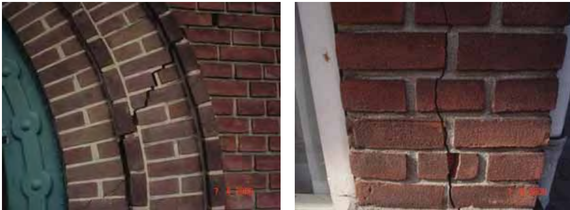
Fig. 1: Schadebeelden als gevolg van trillingen
