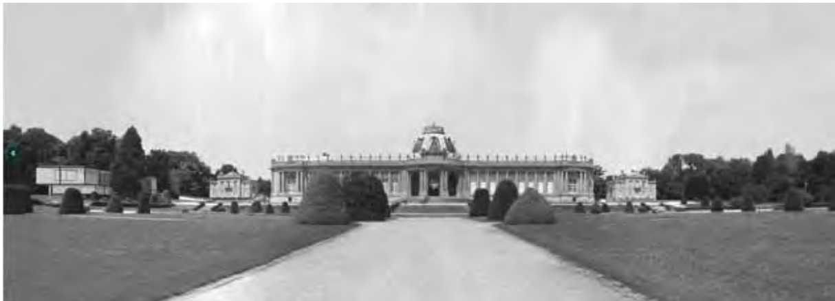
Fig. 8: Zicht op het KMMA met links op de foto het nieuwe inkompaviljoen (bron: www.denys.com )
