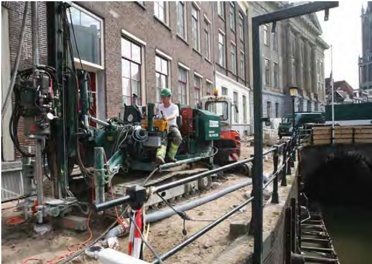
Fig. 3: Rupsboormachine tijdens uitvoering
