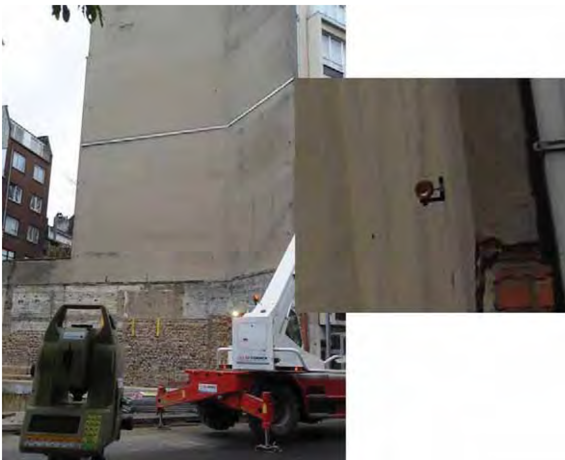
Fig. 2: Bouwput na afbraak van een appartementsgebouw in Brussel: semi-automatische meting van de aanpalende gebouwen
