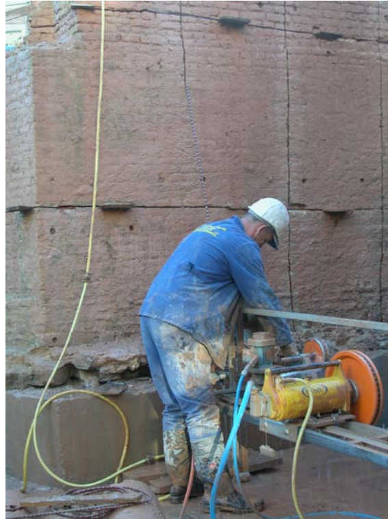
Figuur 5: Verzagen met diamantkoord
