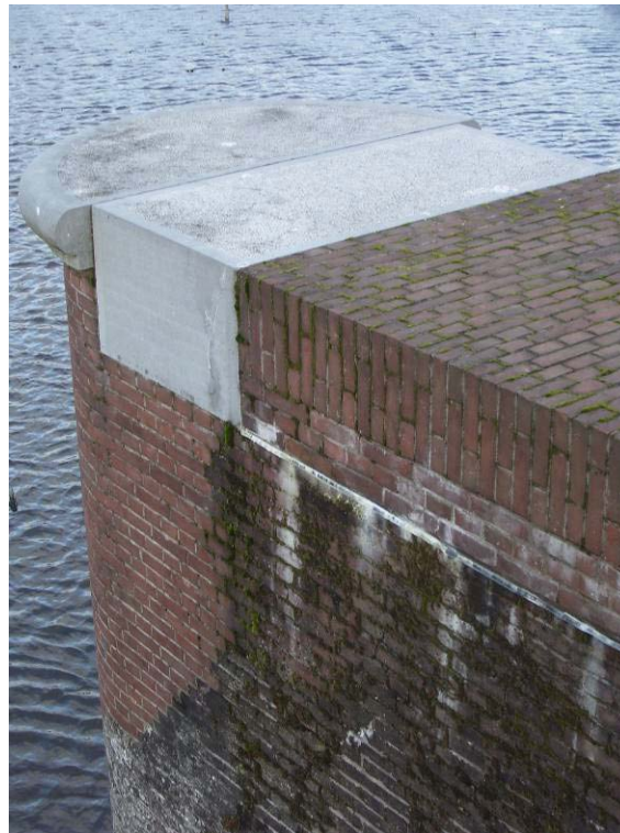
Figuur 5: Proefrestauratie van één van de pijlers: loodslab met druiprand.
