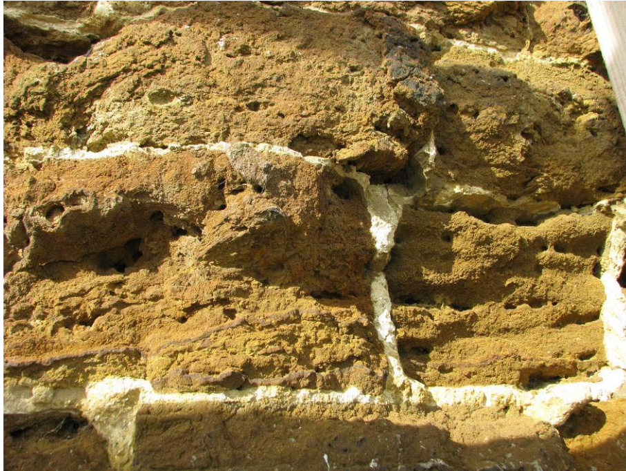
Figuur 2: Ijzerzandsteen gekenmerkt door sterke aantasting ten gevolge van de aanwezigheid van diverse bijengangen
