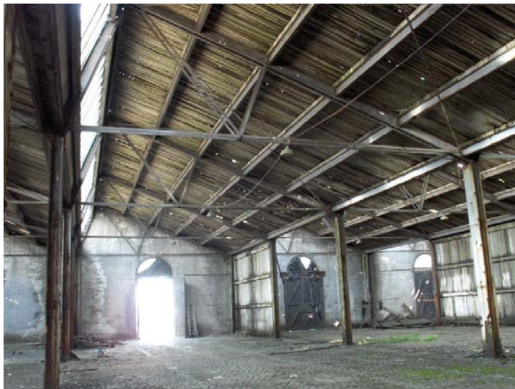
Figuur 6: Beeld van bestaand typespant – staal (bron: fotoarchief ontwerper)
