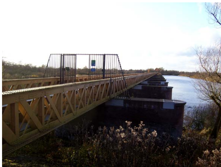
Figuur 1: De Moerputtenbrug anno 2009
