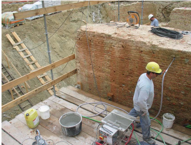
Figuur 4: Consolidatie door injectie
