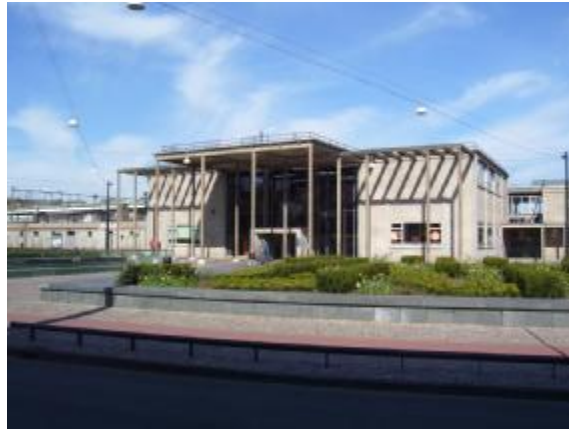
Figuur 1: Station Zutphen, in 1952 gebouwd door H.G.J. Schelling.
