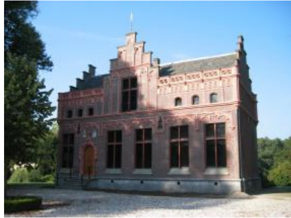
Figuur 2: Voorgevel van het jachtslot Ter Horst na de restauratie
