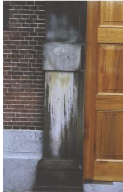
Fig. 8. Donker verkleurde zandstenen deuromlijsting op het Binnenhof in Den Haag. Wanneer gebouwen door hun functie en materiaalsamenstelling extra gevoelig zijn voor schade door graffiti of verwijdering daarvan, kan het aanbrengen van een anti-graffitisysteem raadzaam zijn. © RDMZ, M. v. Hunen
