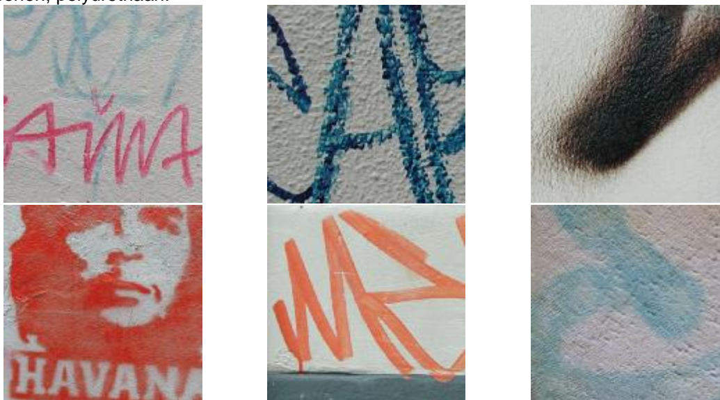
Fig. 14. Verschillende typen graffiti; aangebracht met viltstift, vetkrijt, tectyl, spuitbus en kwast. © RDMZ, M. v. Hunen
