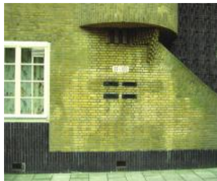
Fig. 7. Plekken waar graffiti zijn verwijderd tekenen zich op de verouderde gevel. © RDMZ, M. v. Hunen
