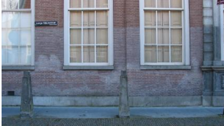
Fig. 28 Veel anti-graffitisystemen vragen onderhoud. In dit geval is graffiti verwijderd en lijkt daardoor een deel van de bescherming verdwenen te zijn. Het is belangrijk dat door de beheerder wordt vastgelegd welke type systeem is aangebracht. De type systeem bepaalt namelijk hoe graffiti moet worden verwijderd en welke onderhoud noodzakelijk is. © Utrecht, Sectie monumenten
