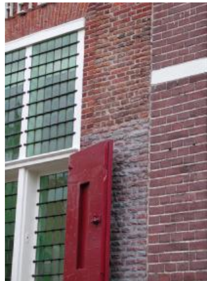
Fig. 19. Monument waarvan het onderste deel van de gevel is voorzien van een permanent anti-graffitisysteem. © TNO Bouw Fig. 20. Detail van de gevel. © TNO Bouw
