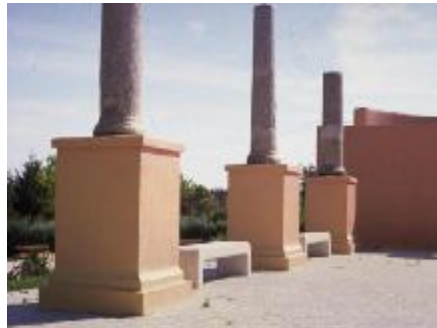
Fig. 28 Veel anti-graffitisystemen vragen onderhoud. In dit geval is graffiti verwijderd en lijkt daardoor een deel van de bescherming verdwenen te zijn. Het is belangrijk dat door de beheerder wordt vastgelegd welke type systeem is aangebracht. De type systeem bepaalt namelijk hoe graffiti moet worden verwijderd en welke onderhoud noodzakelijk is. © Utrecht, Sectie monumenten
