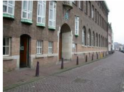
Fig. 26. Gedeeltelijke reiniging van de gevel kan de architectonische eenheid verstoren. Volledige reiniging is veelal niet gewenst of budgettair niet haalbaar. © RDMZ, M. v. Hunen
