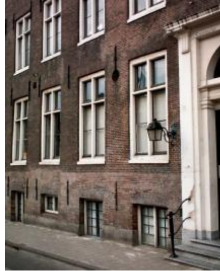
Fig. 5. Herhaaldelijk aanbrengen en verwijderen van graffiti leidt op den duur tot een verstoord gevelbeeld. © RDMZ, E.J. Nusselder
