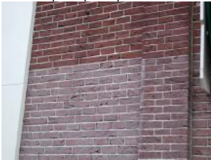
Fig. 9. Door een verkeerde voorbehandeling kan een anti-graffitisysteem wit uitslaan. © RDMZ, M. v. Hunen
