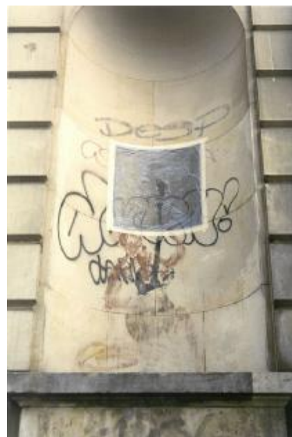
Fig. 17. Rechts. Muiderpoort in Amsterdam. Diep ingedrongen graffiti resten vragen een aanvullende reinigingsbehandeling. © Prochemko, T. van de Weert
