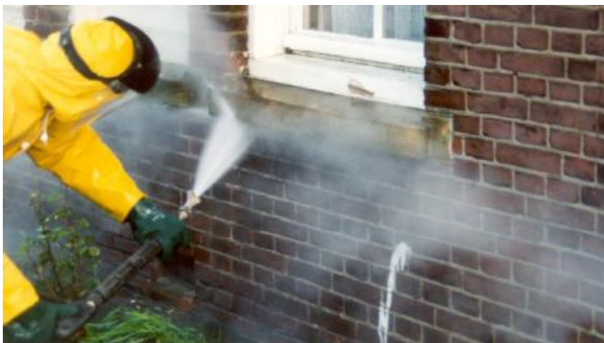
Fig. 30. Met warm water reinigen van de gevel. © RDMZ, M. v. Hunen
