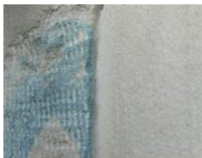
Fig. 12. De verf is zo diep in de zandsteen gedrongen dat deze niet meer zonder schade is laag van de steen te verwijderen. In plaats te verwijderen. © RDMZ, M. Stappers Fig. 13. De bekladding is verwijderd door een gedrongen dat deze niet meer zonder schade is laag van de steen te verwijderen. In plaats daarvan had de graffiti ook overschilderd kunnen worden. © RDMZ, M. Stappers
