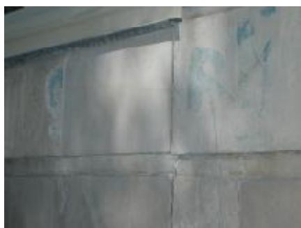
Fig. 12. De verf is zo diep in de zandsteen gedrongen dat deze niet meer zonder schade is laag van de steen te verwijderen. In plaats te verwijderen. © RDMZ, M. Stappers Fig. 13. De bekladding is verwijderd door een gedrongen dat deze niet meer zonder schade is laag van de steen te verwijderen. In plaats daarvan had de graffiti ook overschilderd kunnen worden. © RDMZ, M. Stappers
