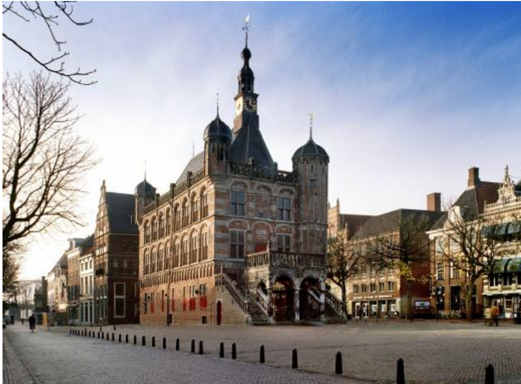
Fig. 1: De Waag in Deventer. Restauratie afgerond in 2002
