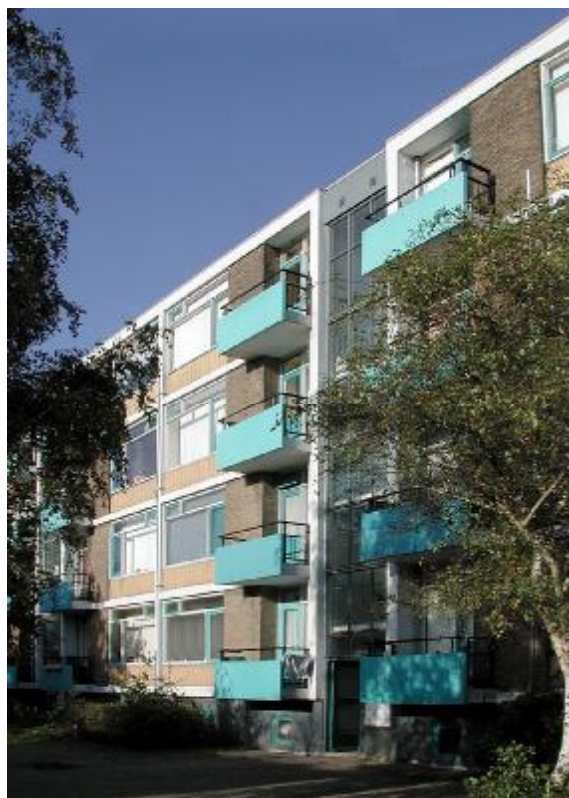
Fig. 3: Woningbouw uit de Wederopbouwperiode (Vlaardingen, Babberspolder-Oost). Deze portieketageflat is nog niet gerenoveerd: het gebouw is nog authentiek en juist daarom – uit monumentenoopt – van zekere waarde. © Bert van Bommel.
