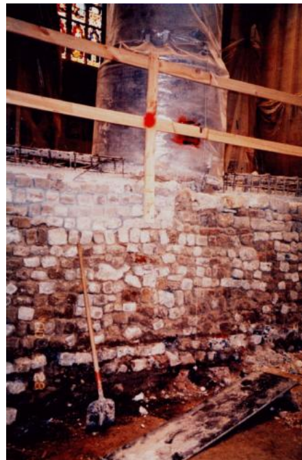
Fig. 3: Kettingmuur onder kolommen
