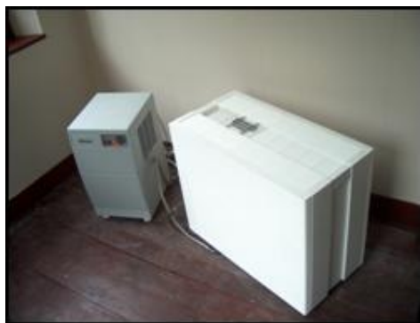
Afb. 5: Het aansturen van be- en ontvochtigers met behulp van sensoren aangesloten op een gebouw-beheersysteem
