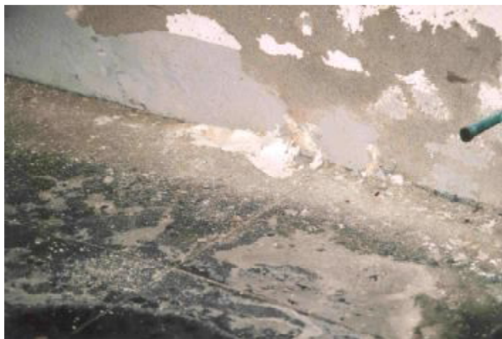
Afb. 14: Lekkende gemetselde kelder na injectie met kaliwaterglas
