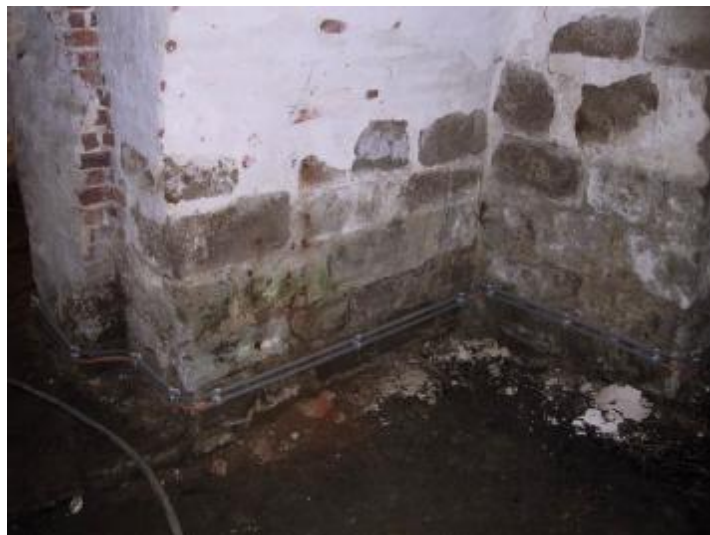
Fig. 9: Vochtprofielmeting ijzerzandsteen
