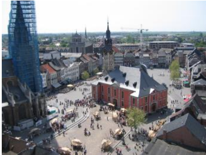
Figuur 7: Marktplein van Sint-Truiden, gelegen ten westen van de toren. In het centrum het Stadhuis, en links de O.L.V.-kerk. Zicht vanop het platform bovenop de toren.
