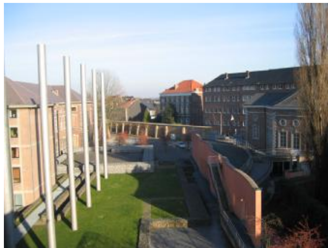
Figuur 6: Kerkveld ten oosten van de toren, met het nieuwe schoolgebouw (links, 1976), Foyer (rechts, 1997) and Academie (1839). Roestvrij stalen zuilen simuleren de vroegere kerkkolommen.
