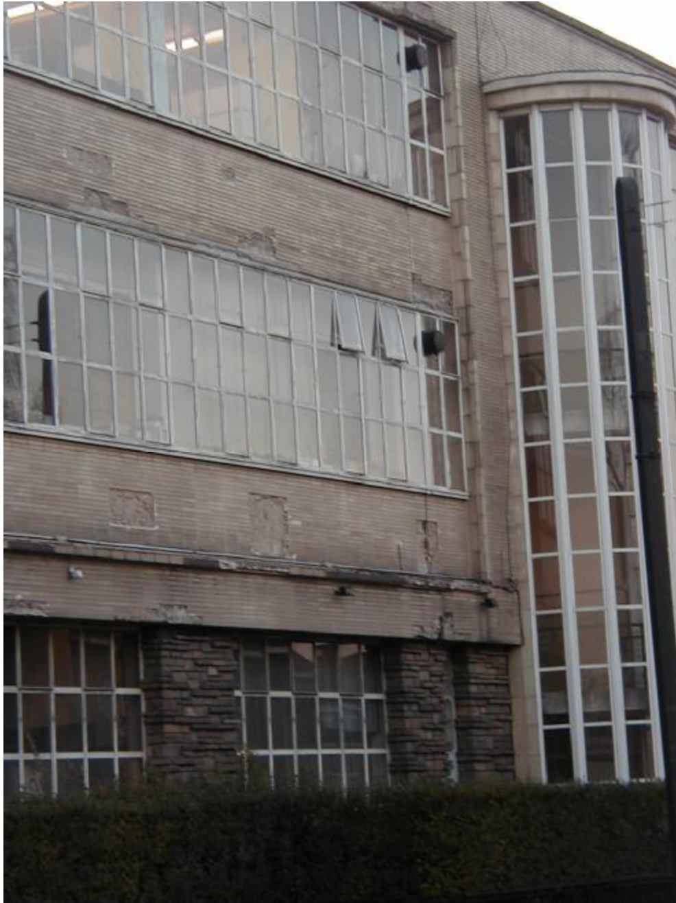
Figuur 6: Gevels van de koksschool COOVI te Anderlecht. De restauratie van de buitenbetegeling is met het erugplaatsen van de tegels niet noodzakelijk afgelopen: de effecten van vocht, nog aanwezig in de gevels, zullen na de restauratie opnieuw leiden tot afvallende tegels. Een nog intensere onderhoudsplanning zal bij dit reeds onderhoudsbehoefte gebouw broodnodig zijn.
