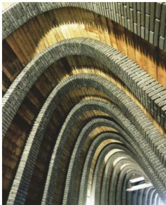
Foto 22: Gemetselde ribben met houten delen
