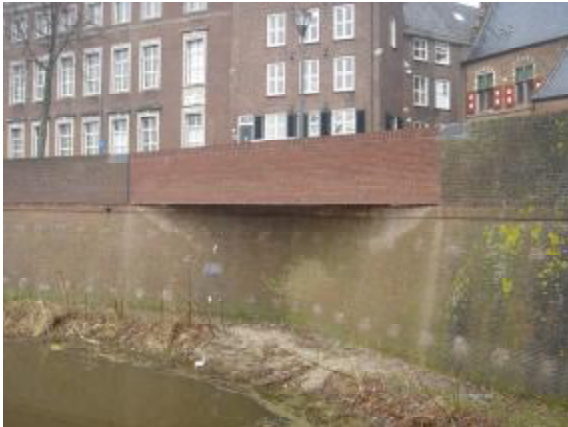
Foto 23: De zelfdragende bakstenen ligger
