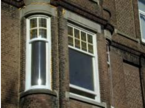
Erker met gebogen glas en glas in lood; tocht en een hoge gasrekening brachten de eigenaar tot drastische maatregelen
