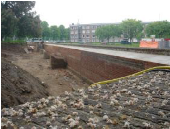
Foto 17: Herstel muurwerk aan de binnenzijde van het bastion
