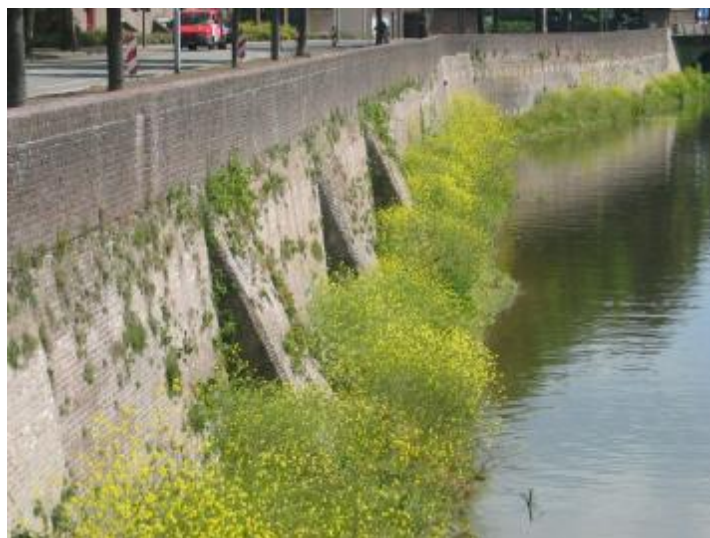
Foto 3: Vestingmuur aan de Zuidwal met steunberen
