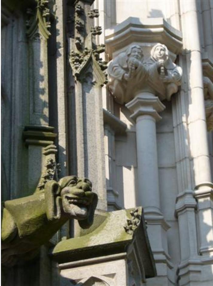
Figuur 5: Restauratiesteen voor beeldhouwwerk (Weidenhahn trachiet, groen verkleurd en Portland kalksteen, wit) aan de noordzijde van het koor. (Foto Rob van Hees, 2006)
