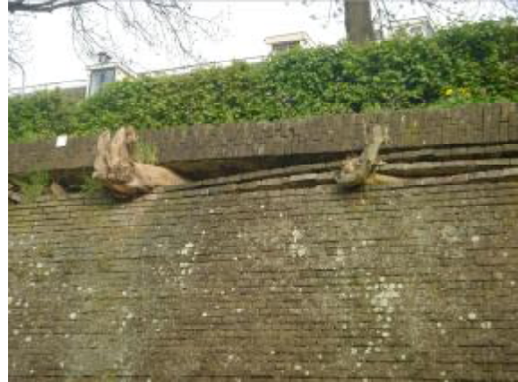
Foto 10: Omhoog gedrukte rollaag
