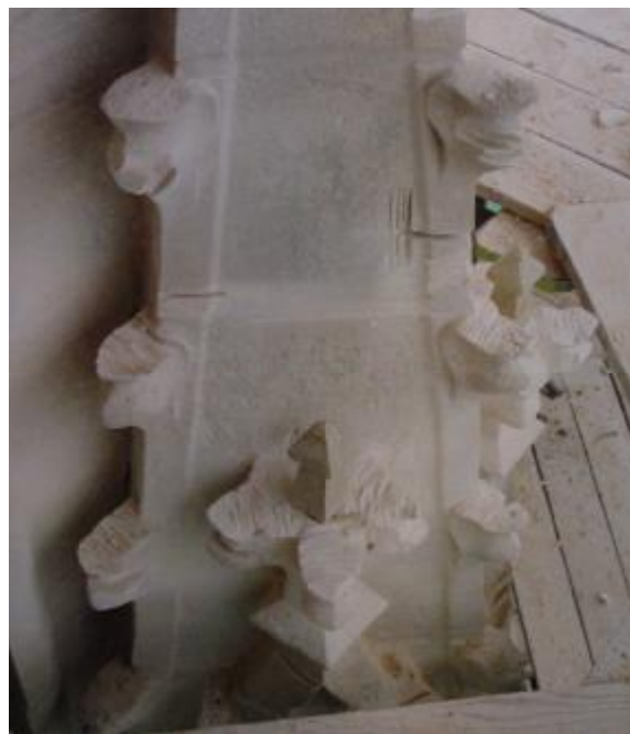
Figuur 11: Benedendakse pinakel, voorbereid om gerepareerd te worden met monulit. De kleine pironnen zijn nieuw gemaakt in Tepla trachiet. (foto: Architectenburo J. van Stigt b.v.)
