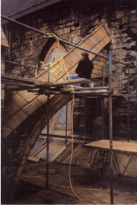
Foto 38: Herstel mergelwerk luchtbogen
