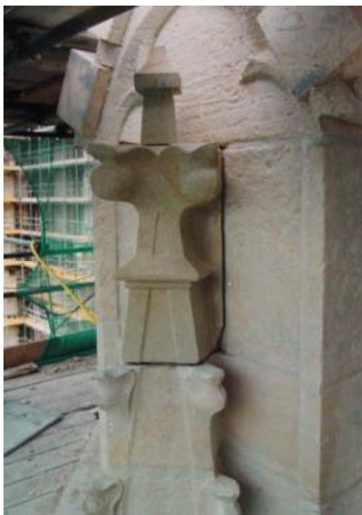
Figuur 10: Benedendakse pinakel deels vervangen in Tepla trachiet. (foto: Architectenburo J. van Stigt b.v.)
