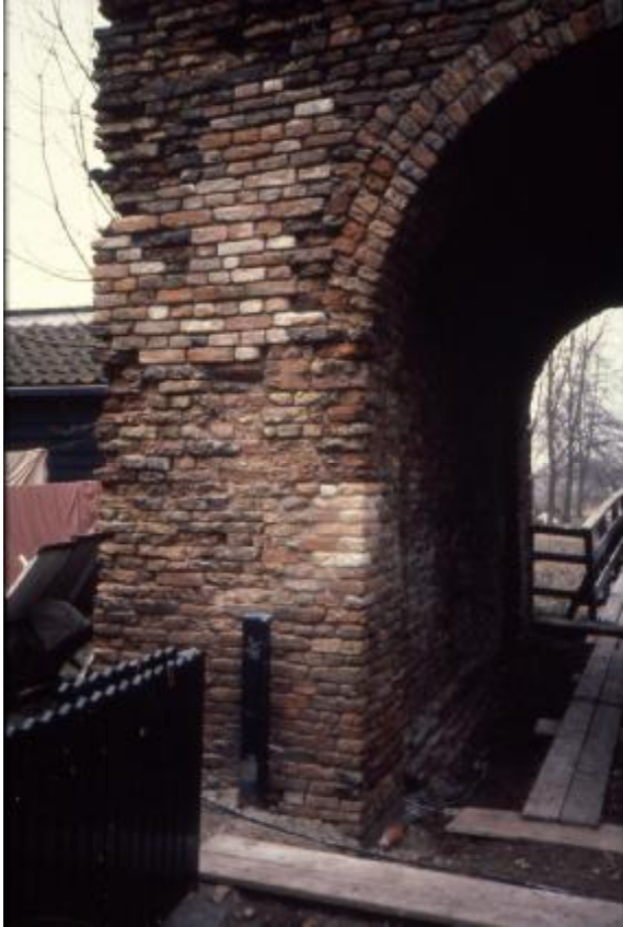
Foto 33: Herstel muurwerk
