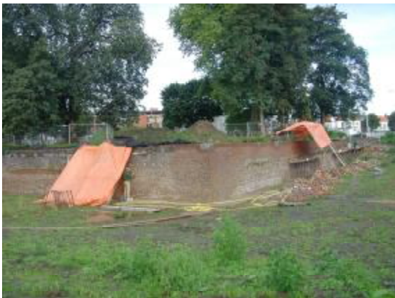
Foto 19: Buitenzijde van het bastion met verlaagd maaiveld
