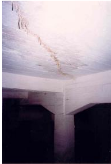
Fig. 4: Scheurvorming in plaathoek (45°)
