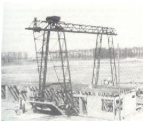
Fig. 7: Betonwoningen in aanbouw volgens systeem Bron te Amsterdam, ca. 1923
