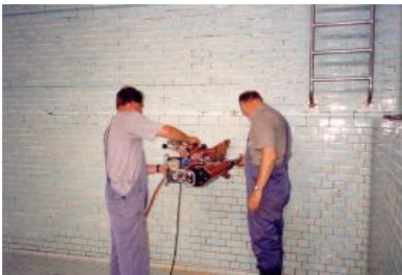
Fig. 10: Kernboring doorheen wand zwembad
