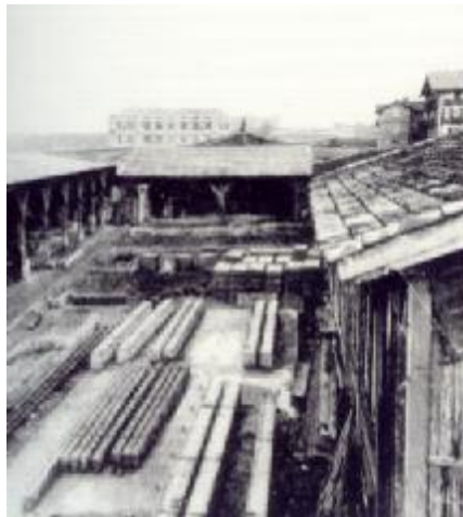
Fig. 1: Opslag van prefab betonbalken voor een casino te Biarritz (1892)
