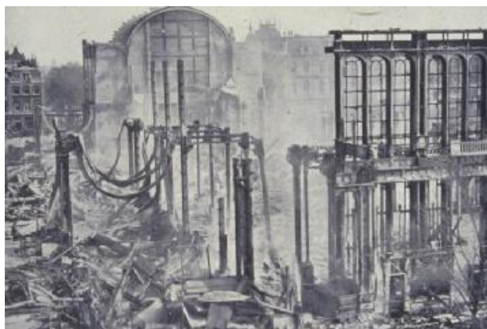
Fig. 13: Het afgebrande Paleis voor Volksvlijt (1864). Afbeelding uit de brochure "Bouwt in Beton! Waarom?"
