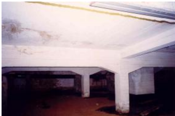
Fig. 4: Scheurvorming in plaathoek (45°)
