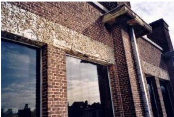
Fig. 8: Zicht op betonnen raamlintelen
