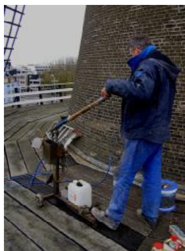
Figuur 12: Proefinjecties. Links: Injectie-apparatuur voor traskalkgrout injectie Rechts: Injectieapparatuur voor polyurethaanhars injectie
