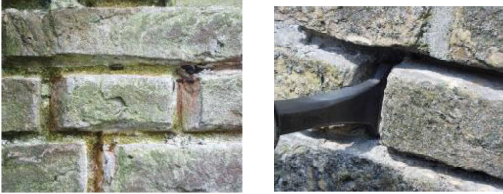
Figuur 9: Links: Onvakkundige verwijdering van voegwerk: grove beschadiging van de stenen; aanzienlijk verbreding van de voeg; V-vorm ipv rechthoekig; diepte voeg tov de breedte onvoldoende. Rechts: Het kan ook goed
