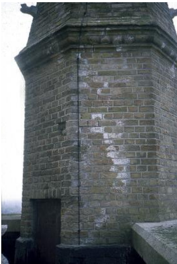
Figuur 2: Toren O.L.V.-Kerk te Gistel na waterwerende behandeling : uitbloei van \text{Na}_2\text{SO}_4 .
