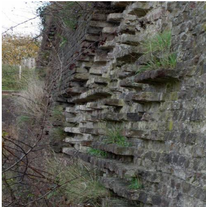
Figuur 8: Maastricht, de hoge Fronten, "Tandvormige" erosie ten gevolge van minder goede hechting tussen strekken en koppen.
