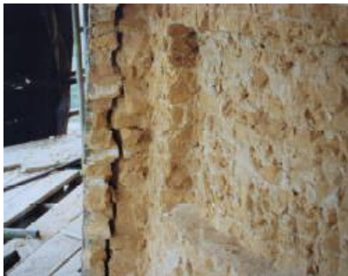
Figuur 1a: Losse schil in molenromp
