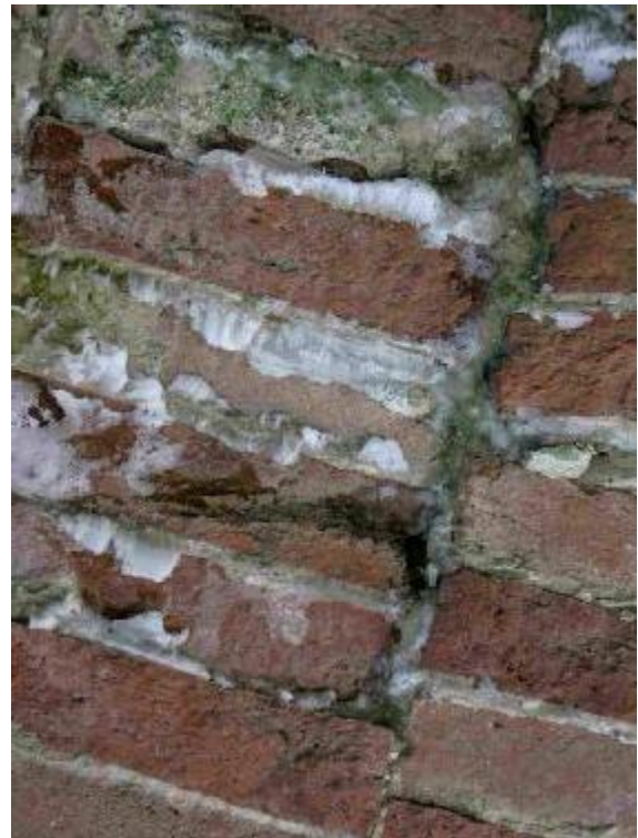
Figuren 5 & 6: Lunet B) Detail van uittredend vocht bij de voegen, dat bij bevroering kristalliseert. Let op de klontjes mortel die op het als bij extrusie uittredend ijs hangen
