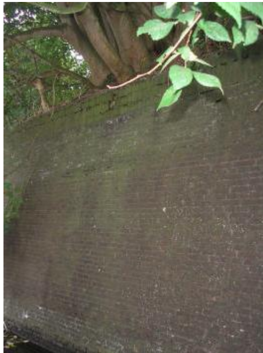
Figuur 15: Detailopname van de oostelijke face van Bastion Katten. Het 130 jaar oude muurwerk verkeerd ondanks, of juist dankzij de boom erbovenop in goede staat.
