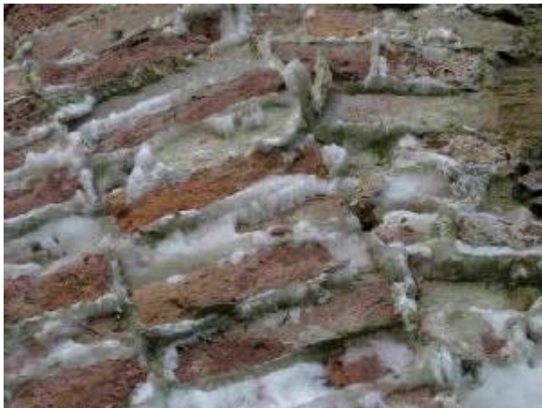
Figuur 3: Lunet B) voor de restauratie met afgeboerde schillen metselwerk.
