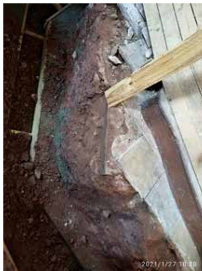
Obrázek 5: Umístění bednění, foto Bartakovics Jan
