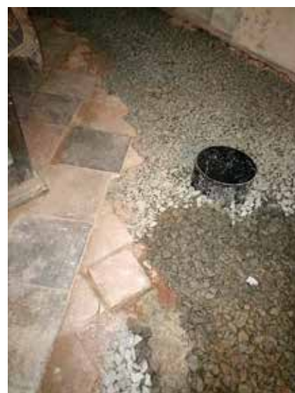
Obrázek 12: Zасыпání a příprava revizního otvoru, foto Bartakovics Jan
