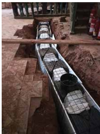
Obrázek 8: Detail odvětrávacího kanálu, foto Bartakovics Jan
