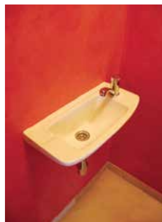
Obř. 13: Avaloka, Stodůlky; Dřevěný skelet, hliněná omítka, lícové hliněné cihly a benátský štuk
