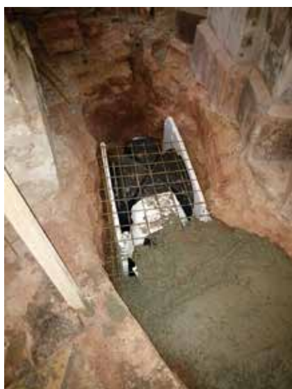
Obrázek 10: Obetonování kanádků, foto Bartakovics Jan
