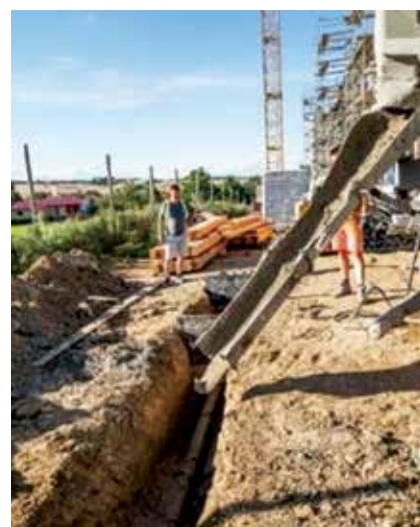
Obr. 11 Odlévání směsi pomocí skluzu do výkopu
