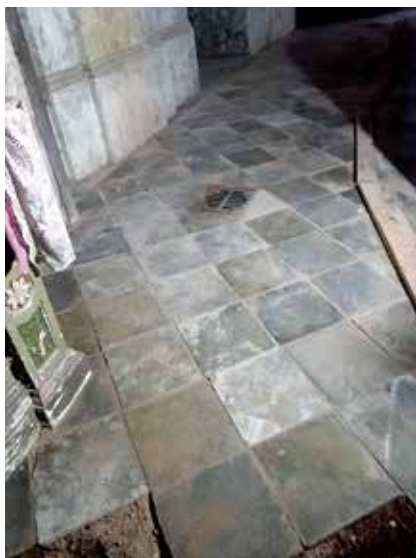
Obrázek 14: Pokládání původní dlažby, foto Bartakovics Jan
