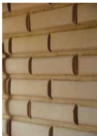
Obř. 13: Avaloka, Stodůlky; Dřevěný skelet, hliněná omítka, lícové hliněné cihly a benátský štuk
