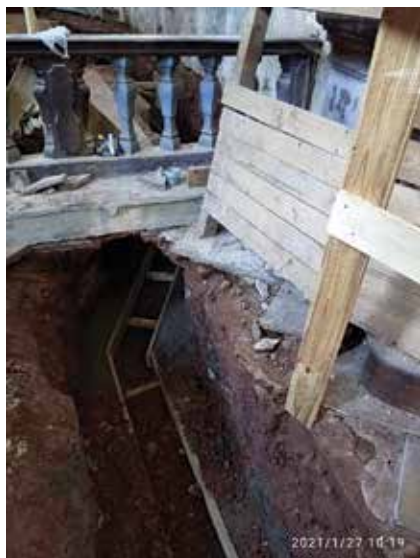
Obrázek 4: Umístění bednění, foto Bartakovics Jan
