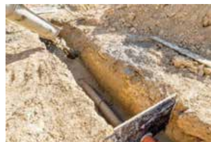
Obr. 11 Odlévání směsi pomocí skluzu do výkopu
