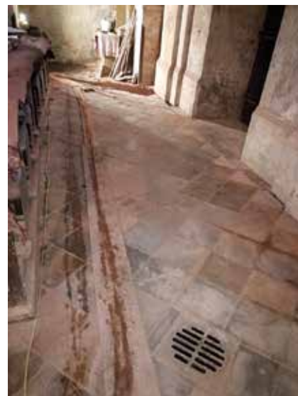
Obrázek 15: Ukončení stavebních prací, foto Bartakovics Jan
