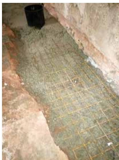
Obrázek 11: Umístění kari sítě nad kanálkem, foto Bartakovics Jan
