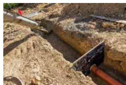
Obr. 12 Rovnoměrné odlévání směsi do výkopu
