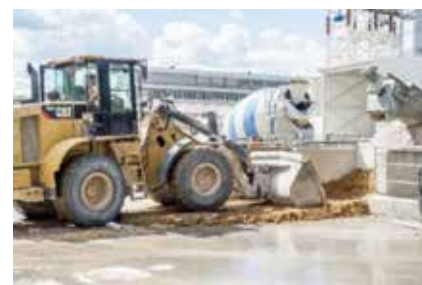
Obr. 3 Úprava zeminy pojezdem kolového nakladače
