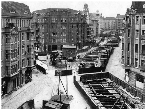
Abb.: U-Bahnbau 1909 (Quelle: Archiv Museum Tempelhof-Schöneberg)
