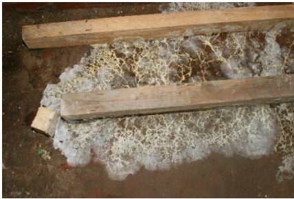
Bild 1: Junges Myzel vom EHS auf dem Kellerfußboden
